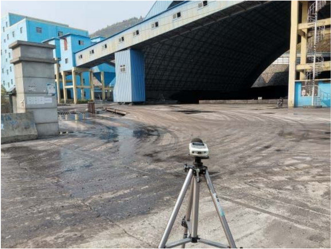
项目厂区、封闭传送带、封闭厂房及噪声现场检查照片
