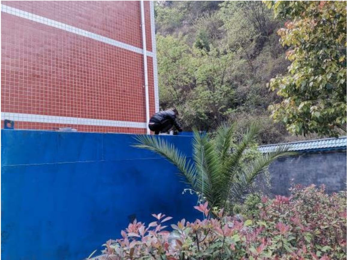
污水一体化处理设备、绿化及现场水样采集图片
