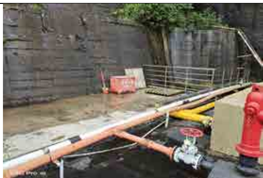
厂房内事故油池
