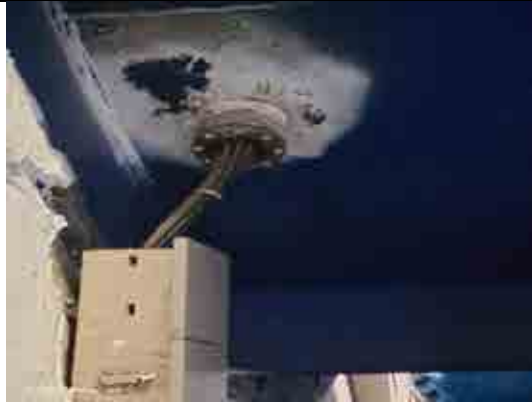
压力钢管上的超声波流量计
