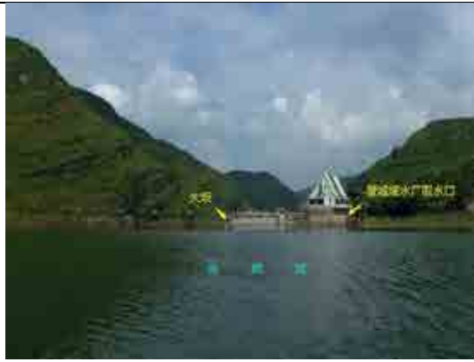
望城坡水厂取水口
