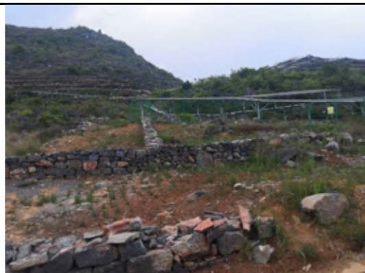
方阵植被恢复及干砌石挡墙
