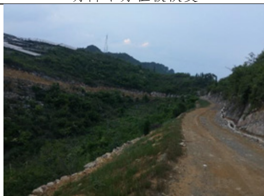
道路边坡植被恢复
