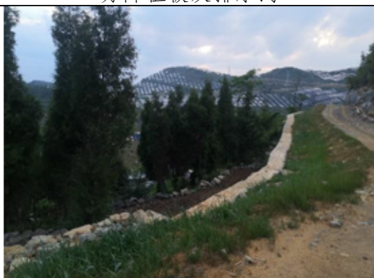
道路边坡植被恢复
