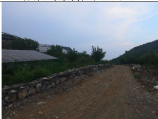
方阵植被恢复及干砌石挡墙
