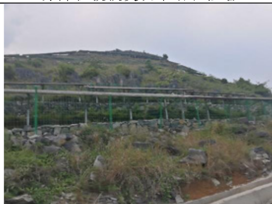
方阵植被恢复及干砌石挡墙
