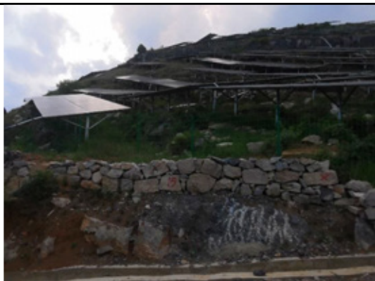
方阵植被恢复及干砌石挡墙
