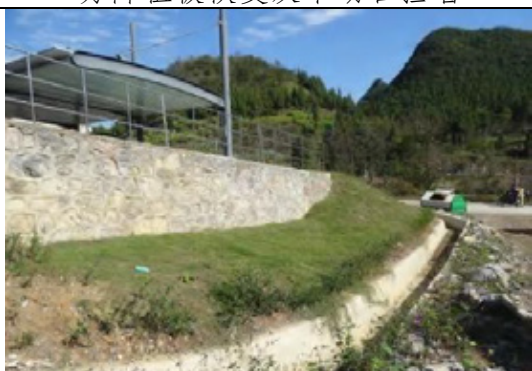
植被恢复、挡墙及排水沟
