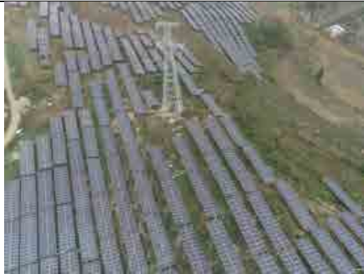
塔基处绿化情况
