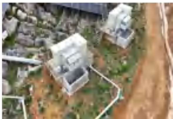
光伏场区箱式变压器
