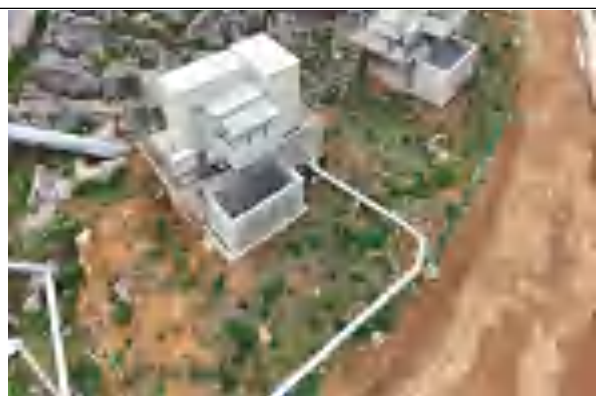
光伏场区箱式变压器事故油池
