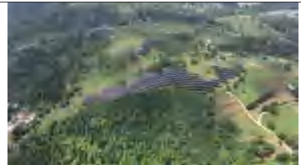
光伏区生态恢复现状
