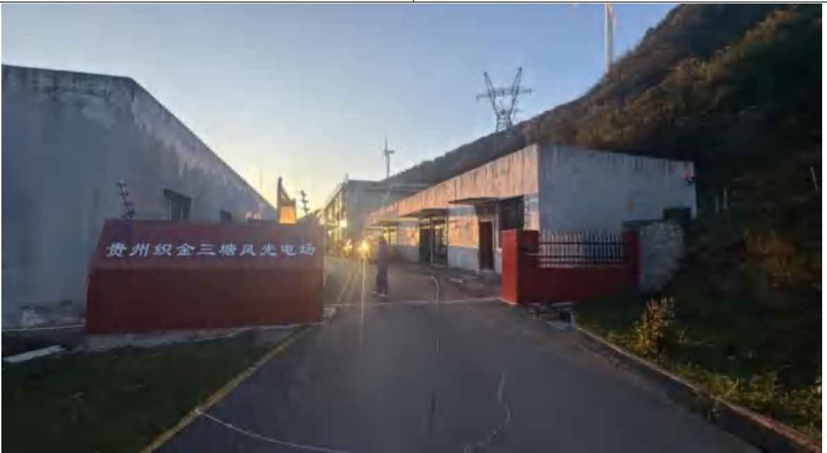
110kV 升压站建设
