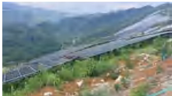
光伏板下方植被现状
