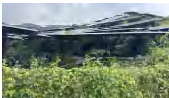
光伏区现状图 4（板下作物）
