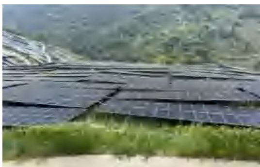
光伏区现状图 3
