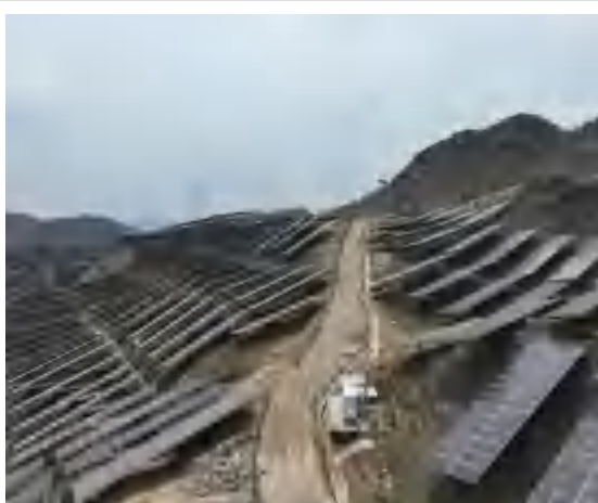
光伏场区箱式变压器
