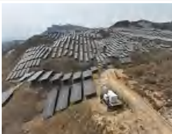
光伏场区箱式变压器
