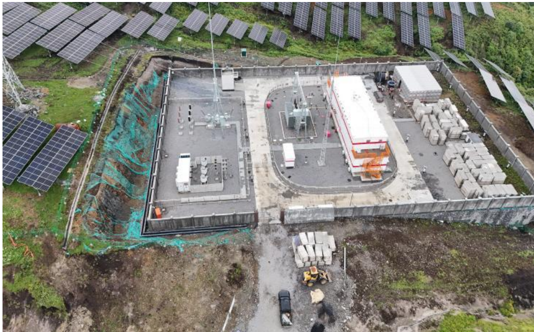
升压站全景照片
