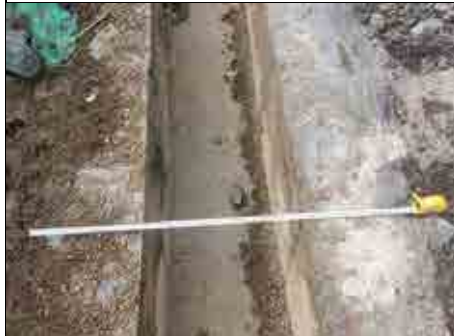
3#地块道路工程区排水沟情况 2
