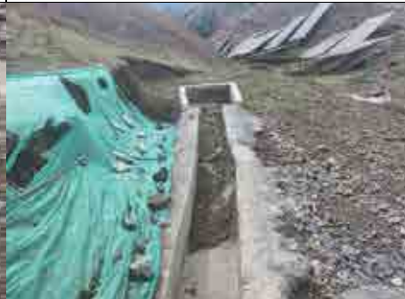
道路工程区沉沙池修建情况
