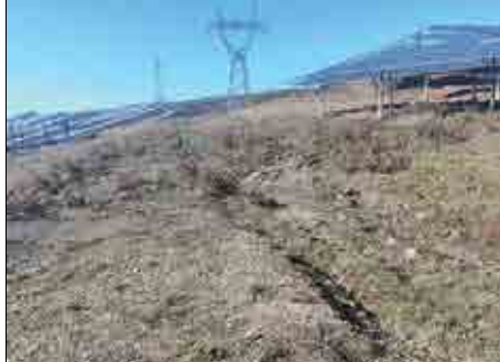
架空线路区塔基恢复情况 3
