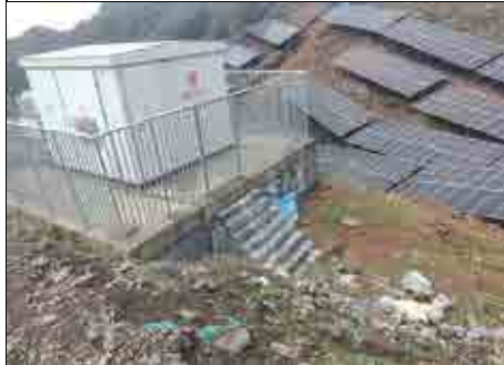
箱变区域植被恢复情况
