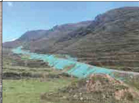
2#地块中道路工程区两侧植被恢复情况
