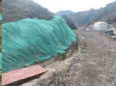
3#地块道路工程区排水沟情况 1
