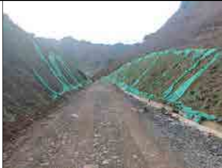
2#地块中道路工程区两侧植被恢复、排水沟情况
