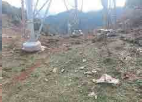
架空线路区塔基恢复情况 2
