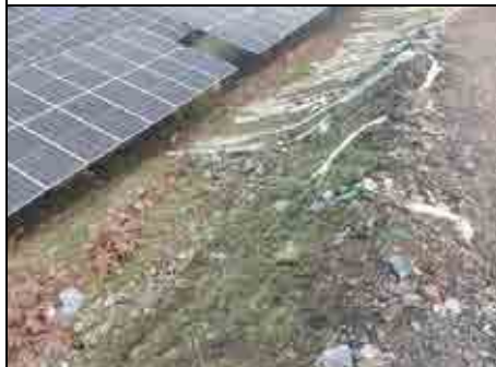
2#地块中道路工程区下边坡植被恢复
