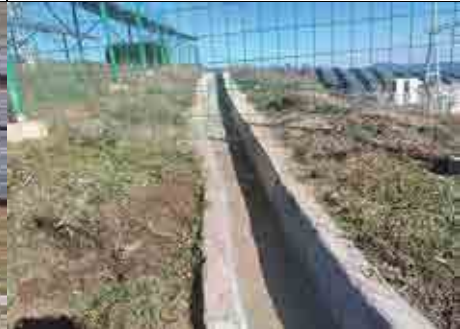
升压站区域截水沟情况
