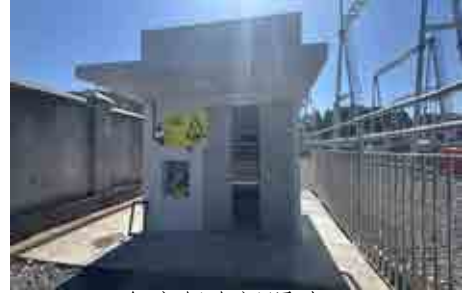
危废暂存间照片 2
