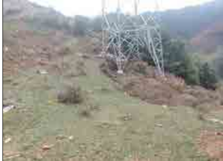
架空线路区塔基恢复情况 1
