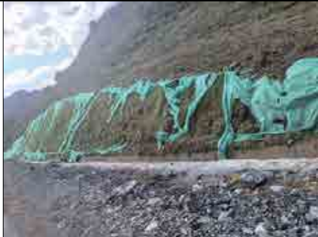
2#地块区域道路工程区排水沟情况
