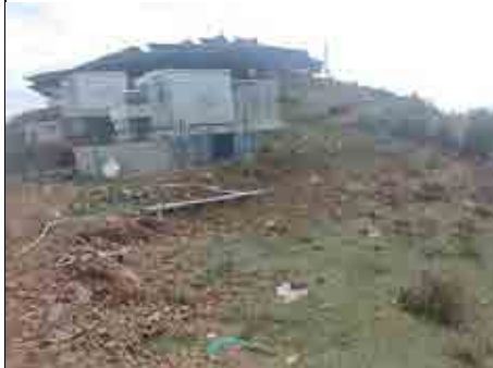
2#地块箱变区域植被恢复情况
