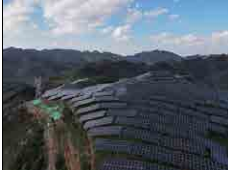
集电线路区 2#地块区域地埋电缆区域植被恢复情况 1
