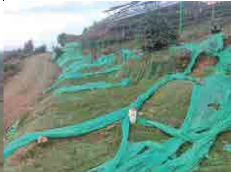
2#地块布板区域植被恢复情况
