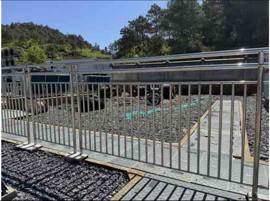
项目事故油池照片
