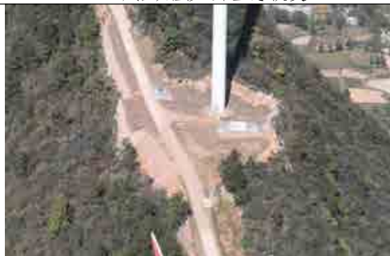
F15 风机及检修道路生态恢复
