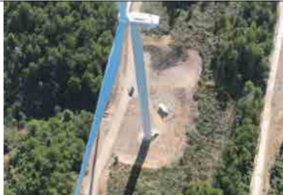
F11 风机及检修道路生态恢复
