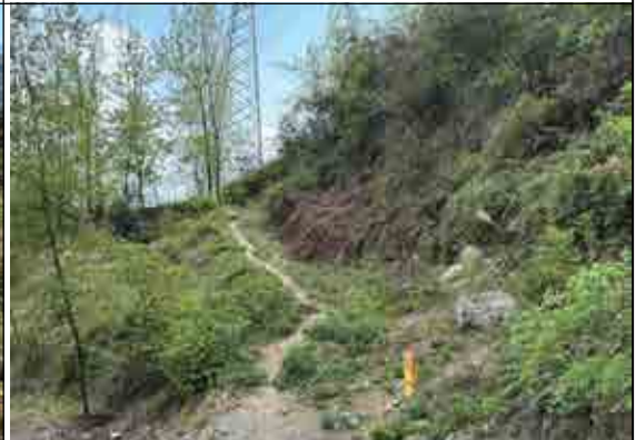
集电线路-塔基、电缆沟现状生态恢复
