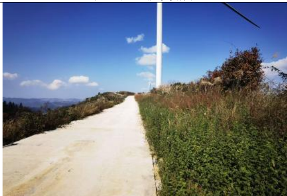
道路工程区恢复情况 10
