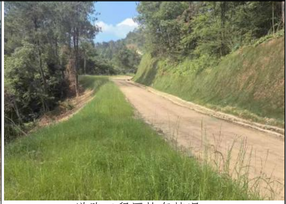
道路工程区恢复情况 5
