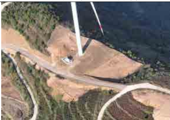
F5 风机及检修道路生态恢复
