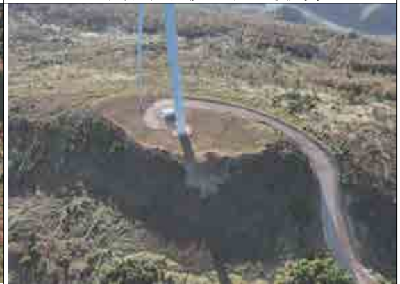
F4 风机及检修道路生态恢复
