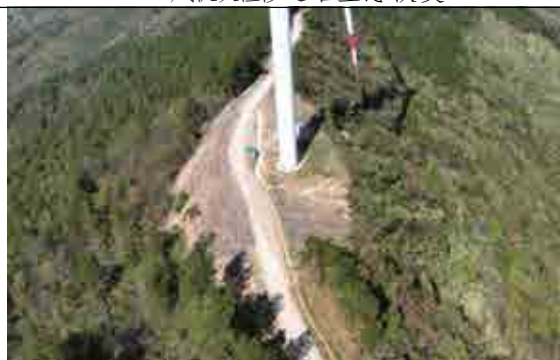
F13 风机及检修道路生态恢复
