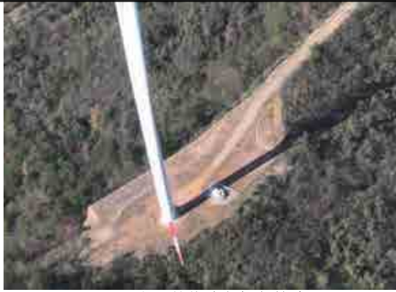
F17 风机及检修道路生态恢复
