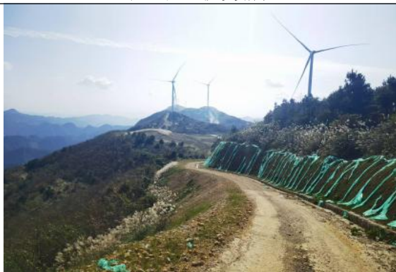
道路工程区恢复情况 8
