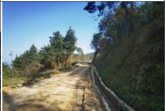
道路工程区恢复情况 9
