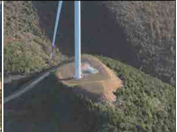
F2 风机及检修道路生态恢复
