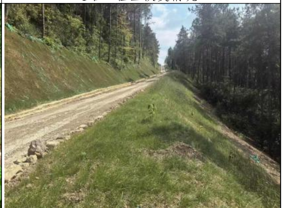
道路工程区恢复情况 3
