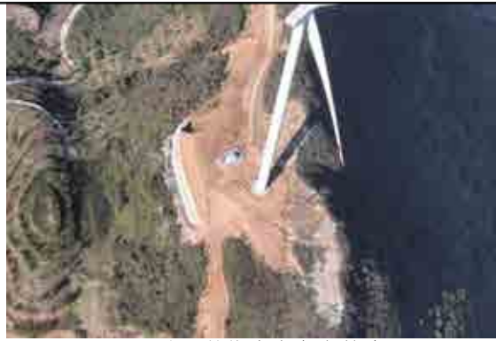
F9 风机及检修道路生态恢复
