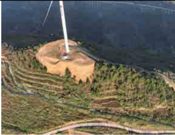
F1 风机及检修道路生态恢复
