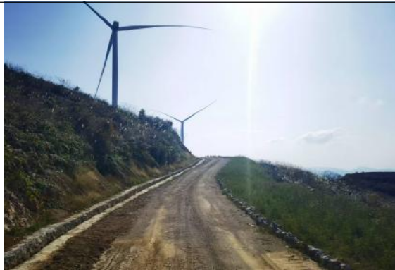
道路工程区恢复情况 6
