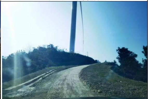
道路工程区恢复情况 11
