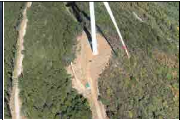
F10 风机及检修道路生态恢复
