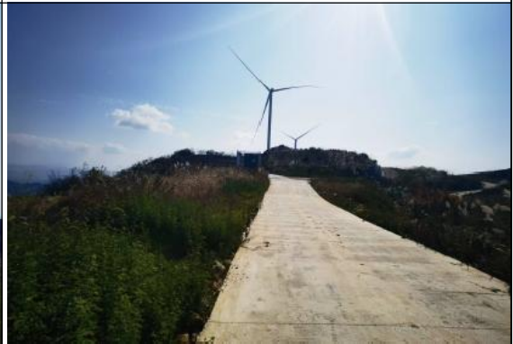
道路工程区恢复情况 7
