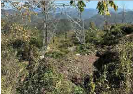
集电线路-塔基、电缆沟现状生态恢复
