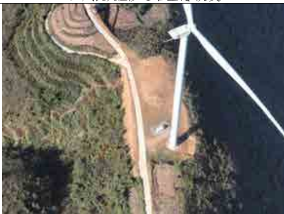
F7 风机及检修道路生态恢复
