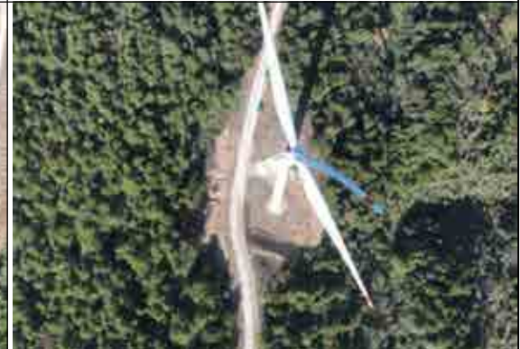
F12 风机及检修道路生态恢复
