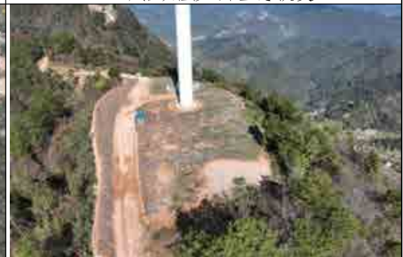
F16 风机及检修道路生态恢复
