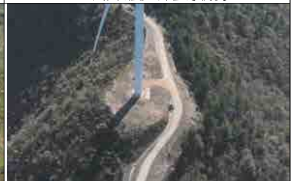
F14 风机及检修道路生态恢复
