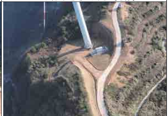
F6 风机及检修道路生态恢复
