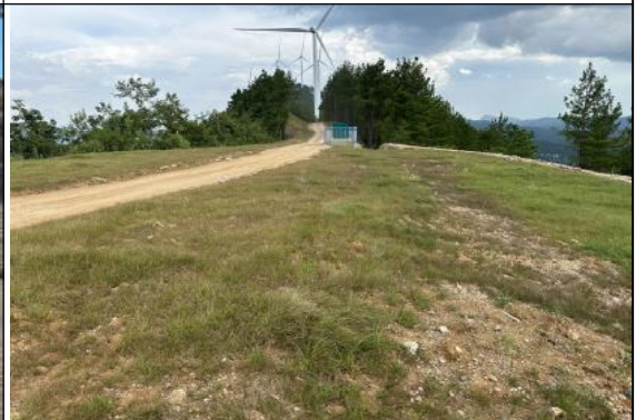
道路工程区恢复情况 1
