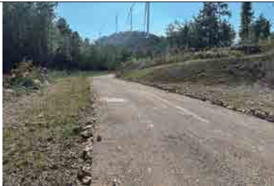
施工检修道路生态恢复
