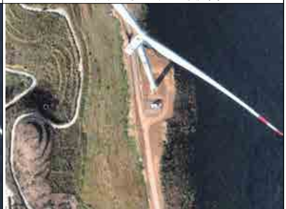
F8 风机及检修道路生态恢复
