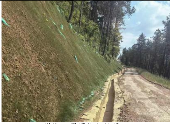
道路工程区恢复情况 4
