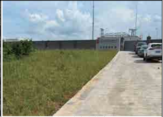
升压站生态恢复
